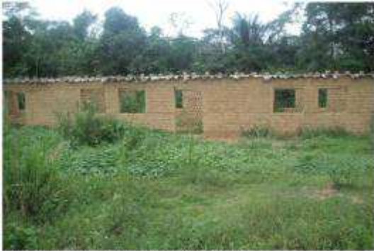
Ecole secondaire de Nongampeta, travaux de construction en arrêt
