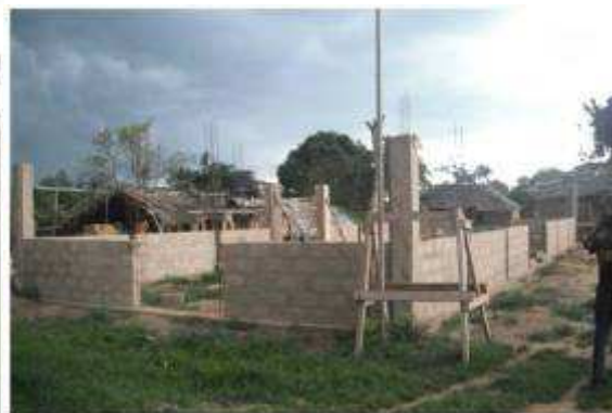
Marché en construction (Construction inachevée) du village LONGO
