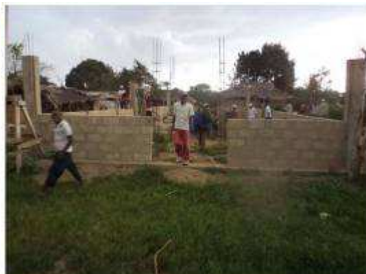
Marché en construction (Construction inachevée) du village LONGO
