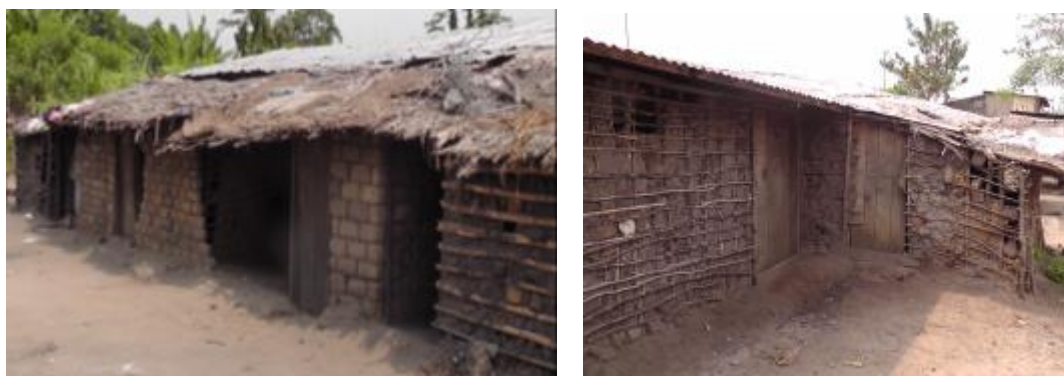
Photo 1. Base- vie des travailleurs de RIBA CONGO
