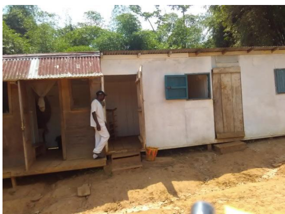
Figure 5: Poste de santé de la base-vie CFT
