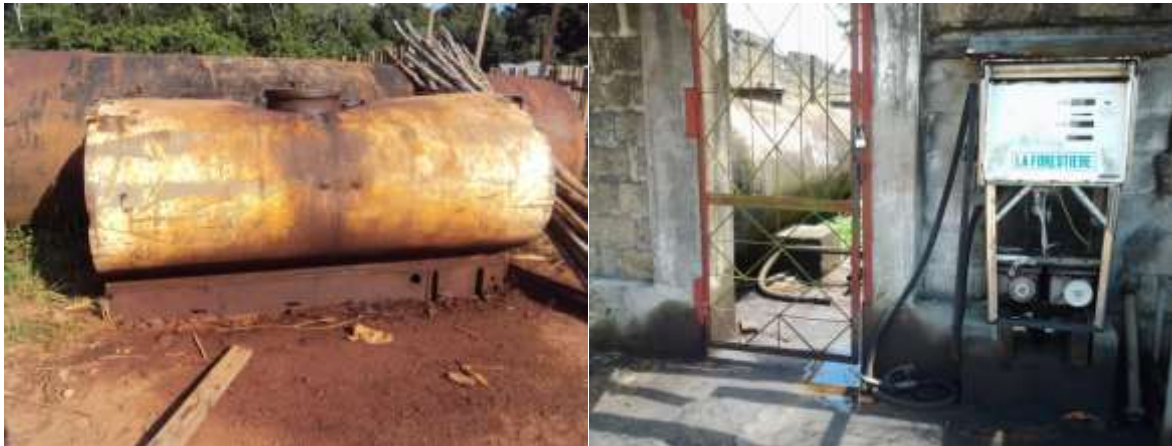
Photo 13. Sol recouvert de gasoil
