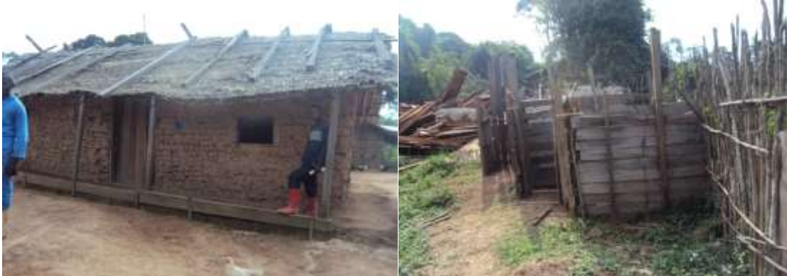
Photo 11. Logement d'un ouvrier et toilette (Base-vie la FORESTIERE (Baliangoma))
