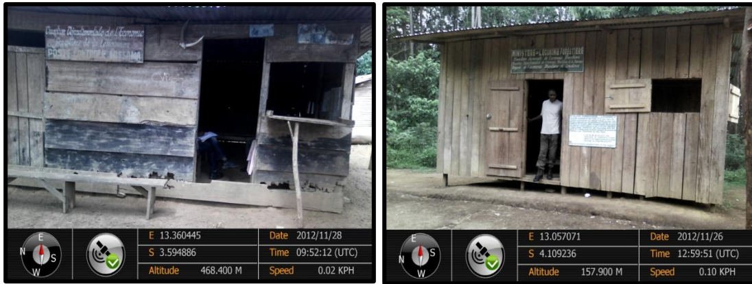
Photo 1: Une vue des bâtiments abritant les poste de contrôle de Missama et Loudima
